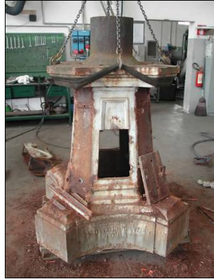
Smontaggio e saldatura
